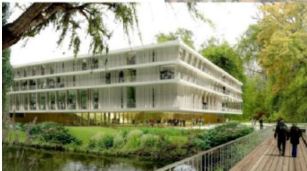
Institut de Mathématiques chantier 2014-2015
