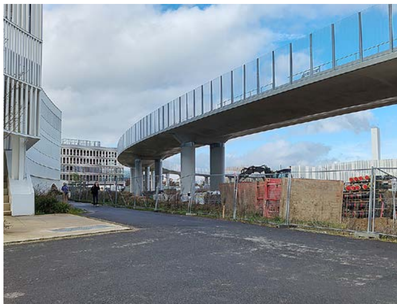
Viaduc de la ligne 18 © UPSaclay
