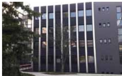
Laboratoire de Physique des Solides Rénovation Patriarche & Co 11 100 m 2 SHON
