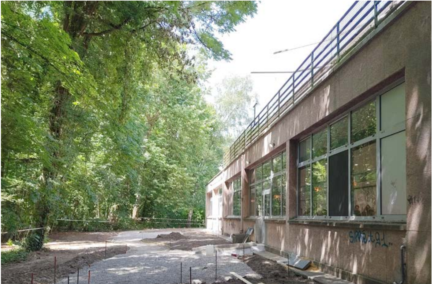
Travaux en cours à l'arrière du bâtiment 230 © PSaclay
