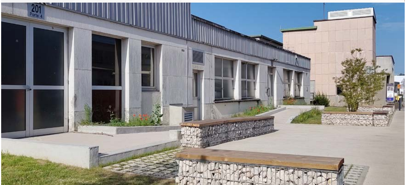
Le parvis du musée pendant les travaux © UPSaclay
