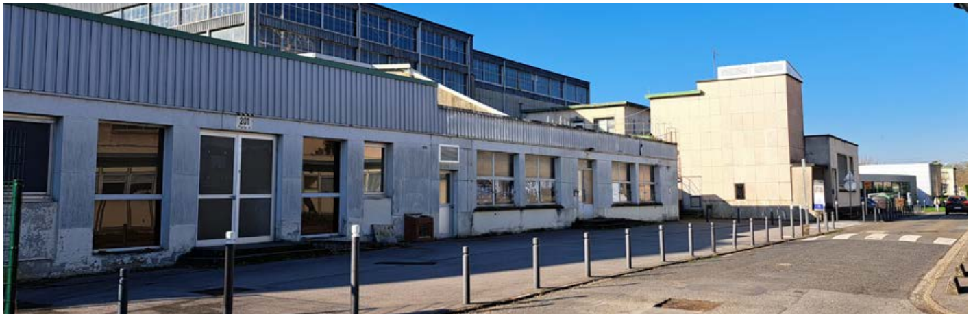
Le parvis du musée avant les travaux © UPSaclay
