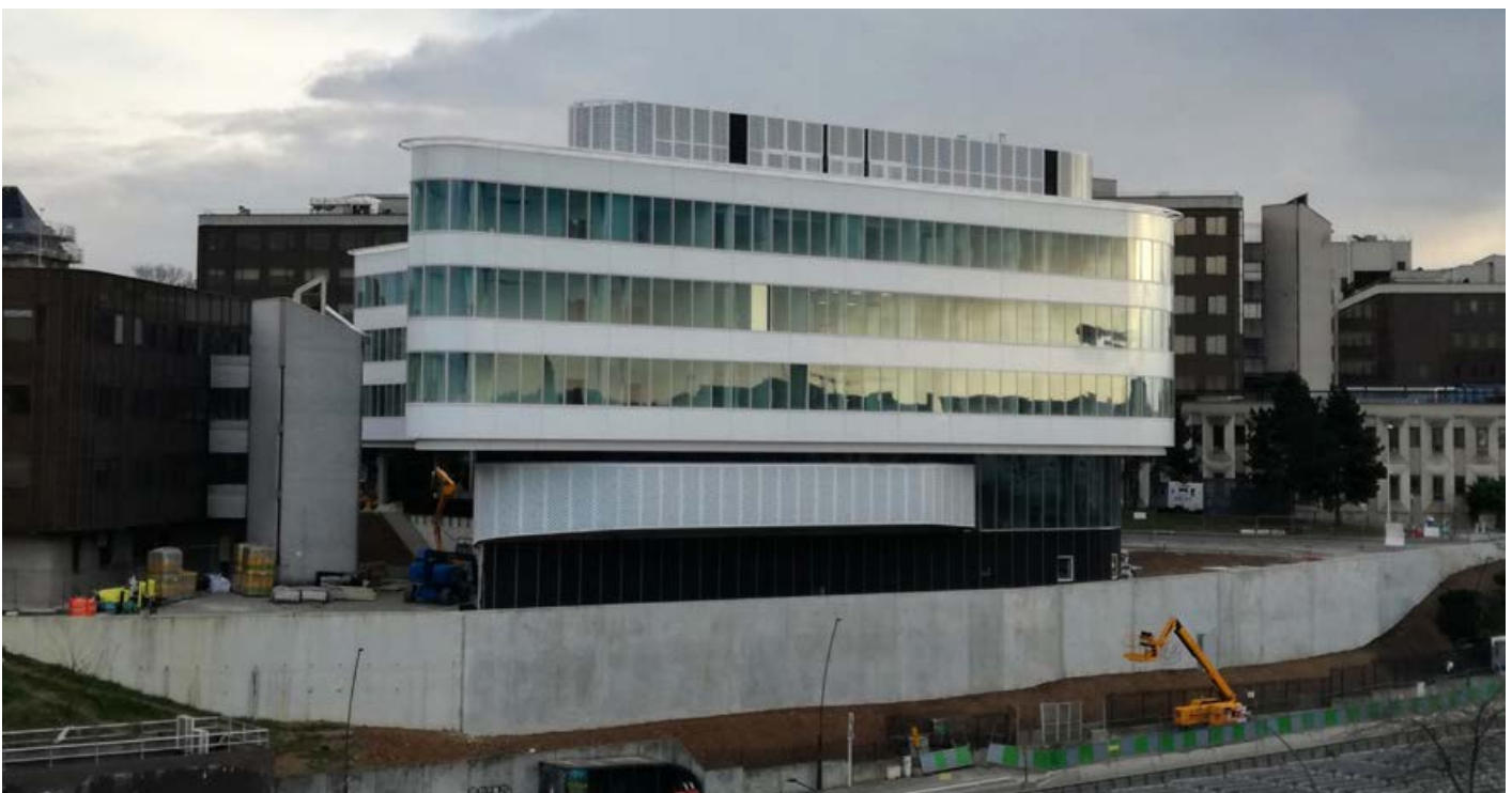
Bâtiment de recherche de la Faculté de Médecine © Tching Kanehisa-Kao
