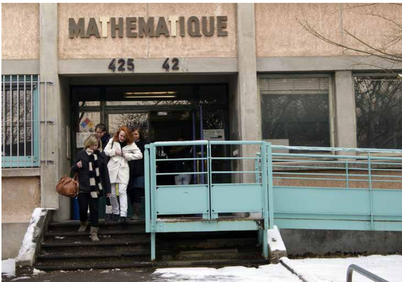
Le bâtiment 425 fait l'objet depuis plusieurs années d'une opération de rénovation, qui se poursuivra grâce au CPER 2022 - 2027. © L. Arduin
